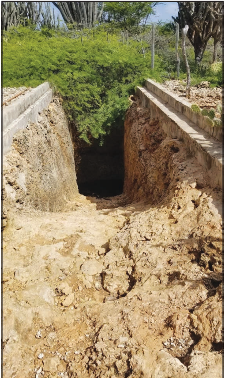
Esaki ta un pos di pia basta grandi den Bakuna. A pone un konstrukshon di betòn na e pos aki.
